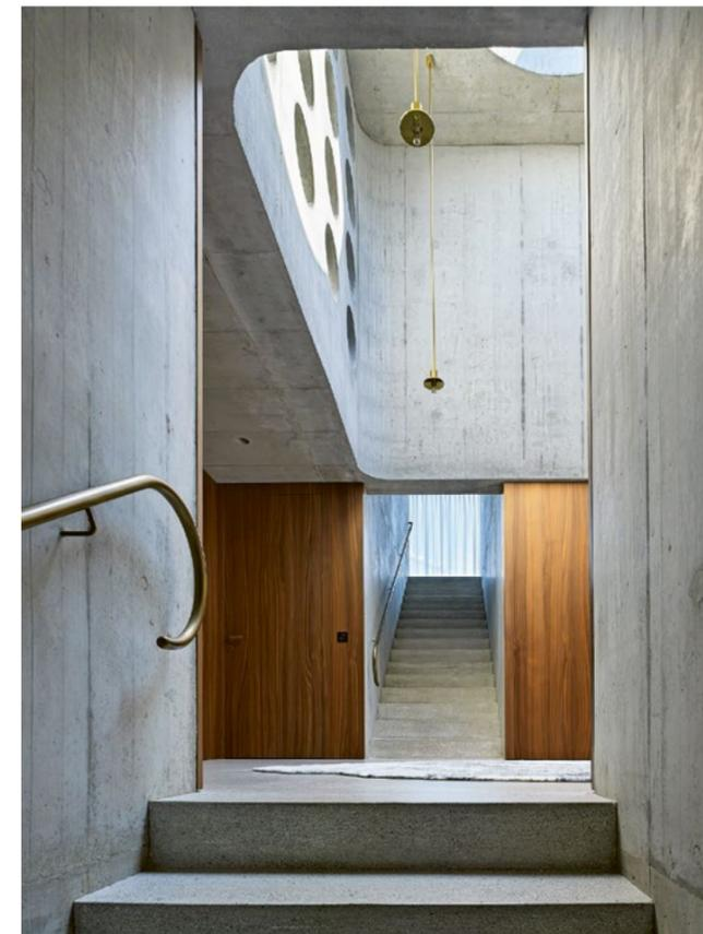
Die Nussbaum-Holzfläche rechts des Elternschlafzimmer-Fensters ist ein Lüftungsfügel, auf der Aussenseite mit perforiertem Blech versehen, das die Durchlüftung erlaubt und gegen Absturz sichert.
