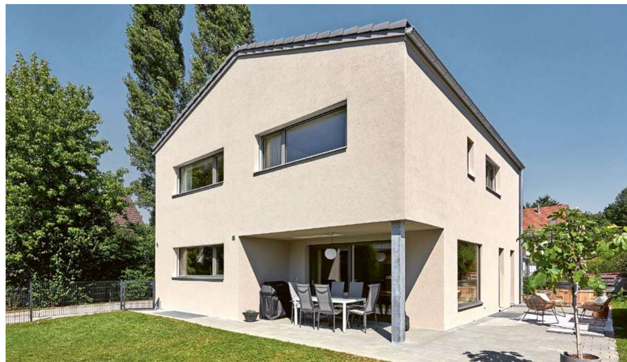
Individuelles Einfamilienhaus mit Einsteinmauerwerk. Bauzeit: 9 Monate.
